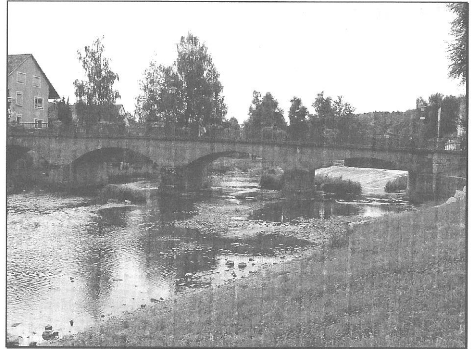
Die Bogenbrücke in Creglingen – Hauptzugang zur Altstadt
